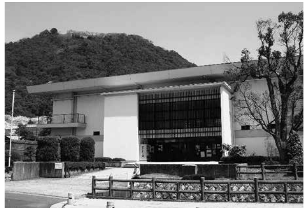
県から市に移管された鳥取市武道館
