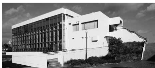
米子市皆生市民プールの外観
